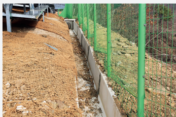
〈태양광 배수로 정비〉
