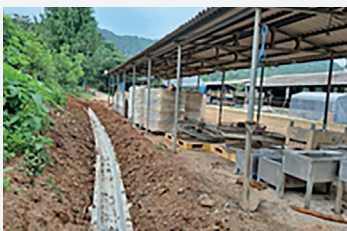
〈축사 배수로 정비〉
