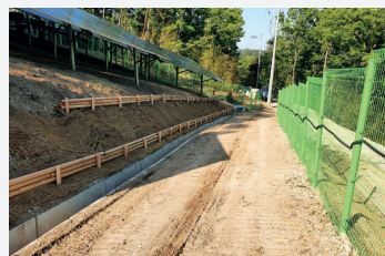
〈태양광 보완시공(통나무 얹기)〉
