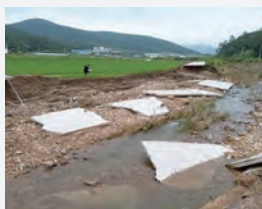
진도 군내천 제방 유실
