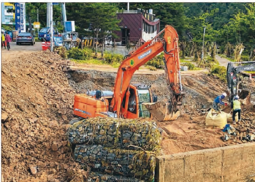
25일 오전 경북 포항시 북구 죽장면 국도31호선 입암교 주변에서 작업자들이 끊긴 연결도로를 복구하고 있다. 이곳 연결도로는 전날 태풍 '오미이스' 영향으로 많은 비가 내리면서 물에 떠내려갔다. 독자 제공
