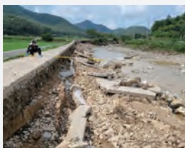
강진 상흥천 제방 유실
