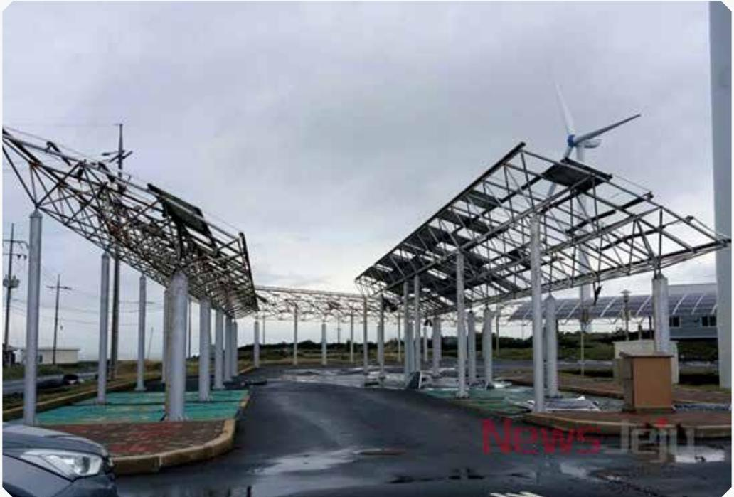
[사진 3-7-3] 제18호 태풍 차바(CHABA)가 동반한 강풍으로 폐허가 된 신재생에너지홍보관 내의 태양광 패널 (뉴스 제주. 2016.10.5.)
