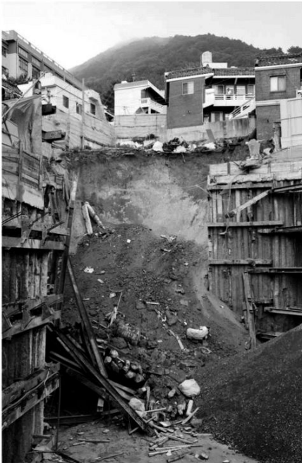
2일 공사 중 흙막이가 무너져 내리는 사고가 발생한 부산 사상구 엄궁동의 한 교회 신축공사장. 이 사고로 인명피해는 없었지만 인근 주민들이 긴급 대피하는 등 소동이 발생했다. 김병집 기자 msk@
