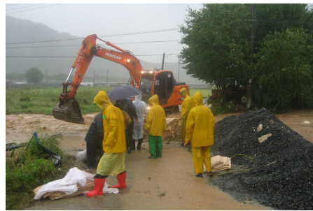
[사진 3-11] 태풍피해로 무너진 도로 및 제방 응급복구
