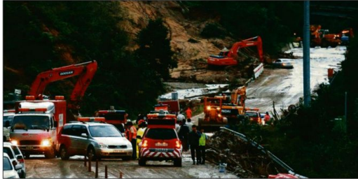
사라진 도로 제16호 태풍 '산바'가 불고 온 폭우로 산사태가 난 경남 함양군 수동면과 거창군 남상면을 지나는 68고속도로 확장구간에서 거창(아래)까지 ksh@hani.co.kr
